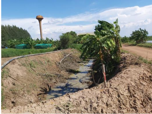
รูปที่ 45 การขุดลอกและทำความสะอาดระบบท่อและรางระบายน้ำเสีย
