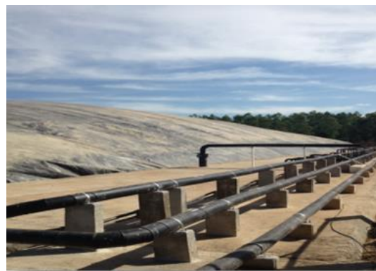
รูปที่ 28 ป่อกากสาปัดคลุมด้วย HDPE และตาข่าย
