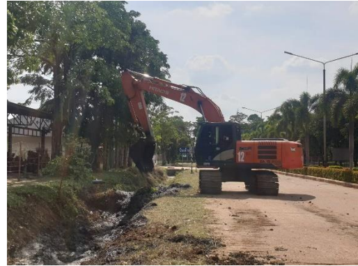
รูปที่ 45 การขุดลอกและทำความสะอาดระบบท่อและรางระบายน้ำเสีย
