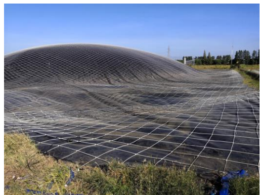
รูปที่ 28 ป่อกากสาปัดคลุมด้วย HDPE และตาข่าย
