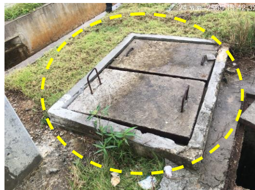
รูปที่ 40 ระบบบำบัดน้ำเสียแบบถังเกรอะจากอาคารสำนักงาน
