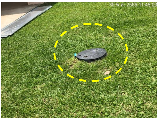
รูปที่ 40 ระบบบำบัดน้ำเสียแบบถังเกรอะจากอาคารสำนักงาน
